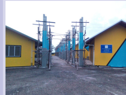
Basisschool die gerenoveerd wordt
